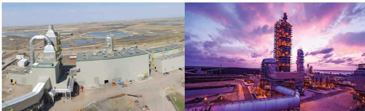
Rys. 3.16 Widok wielkoskalowych instalacji wychwytu CO 2 , Boundary Dam oraz Petra Nova (Boundary Dam CCS – po lewej, Petra Nova CCS – po prawej)
